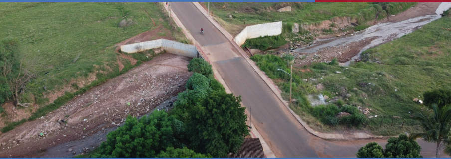
CONSTRUÇÃO DA PONTE INTERLIGANDO A VILA MAMED AO JARDIM MORUMBI
