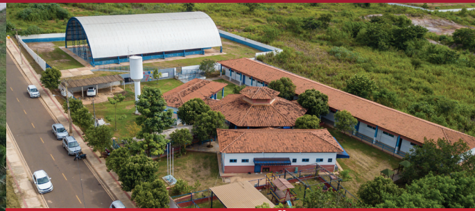
REFORMA E AMPLIAÇÃO DO ESPAÇO DA ESCOLA ALFREDO DE CASTRO E CONSTRUÇÃO DA QUADRA COBERTA JD. MARIA TEREZA
