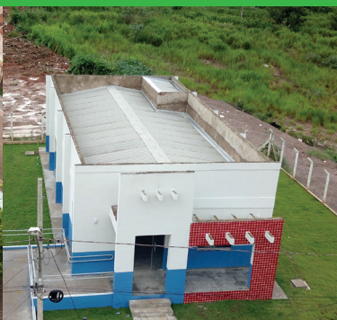
CONSTRUÇÃO DE CENTRO MÚLTIPLO USO NO RES. FIUCA/MAGNÓLIA
