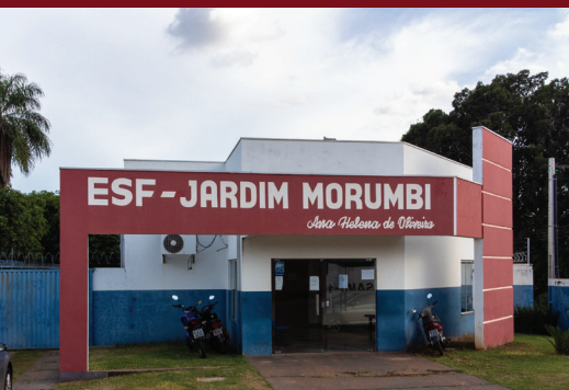
CONSTRUÇÃO DA UBS JARDIM MORUMBI
