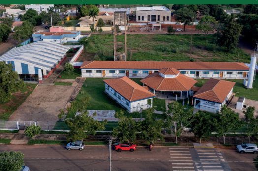
CONSTRUÇÃO DE ESCOLA NA VILA GOULART
