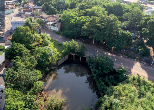
CONSTRUÇÃO DO NOVO ACESSO DA AV. RUI BÁRBOSA INTERLIGANDO O CENTRO A VILA CANAÃ
