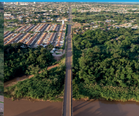
CONSTRUÇÃO DA AV. W11 EM PARCERIA COM GOVERNO DO ESTADO
