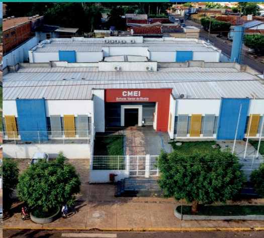
CONSTRUÇÃO DA CRECHE ANTONIO VANIER NA VILA LOURDES
