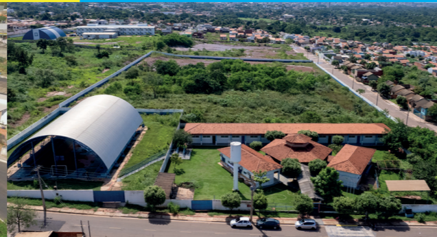
AMPLIAÇÃO DA ESCOLA ALFREDO DE CASTRO NO BAIRRO MARIA TEREZA
