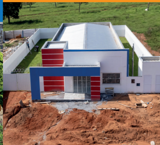
EM ANDAMENTO CONSTRUÇÃO UNIDADE BÁSICA DE SAÚDE NO MARIA AMÉLIA
