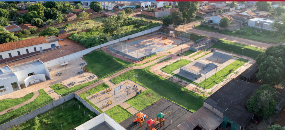
CONSTRUÇÃO DE ÁREA DE LAZER NO VERDE TETO
