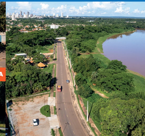
CONSTRUÇÃO DA AV. BEIRA RIO (CALÇADA, ILUMINAÇÃO, URBANIZAÇÃO)
