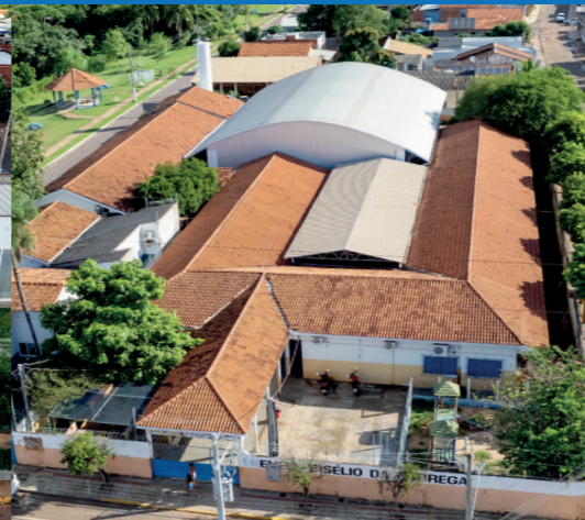
REFORMA DA ESCOLA GISÉLIO DA NÓBREGA E CONSTRUÇÃO DA QUADRA ESPORTIVA
