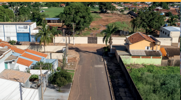
DRENAGEM NAS RUA MATO GROSSO COM ALAGOAS ATÉ O RIO VERNELHO EVITANDO INUNDAÇÕES NO BAIRRO BOA ESPERANÇA E REGIÃO
