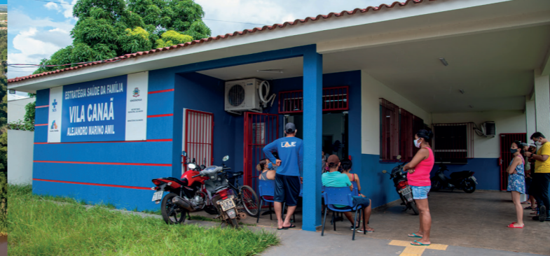
REFORMA DA UNIDADE DE SAÚDE DA VILA CANAÃ
