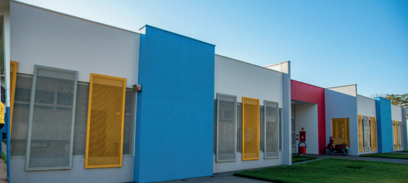
CONSTRUÇÃO DA CRECHE JONAS NUNES CAVALCANTE NA AV. TIRADENTES
