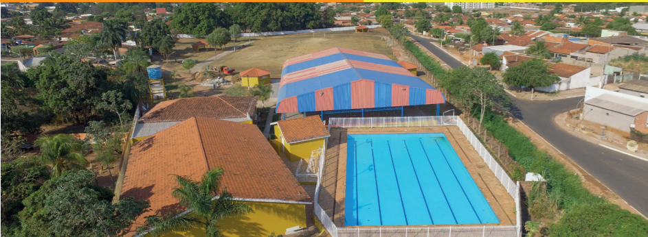
REFORMA DA VILA OLÍMPICA (PISCINA, QUADRA COBERTA, CAMPO DE FUTEBOL)
