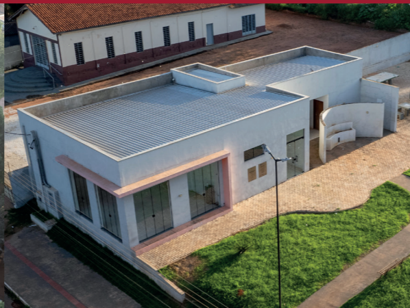
CONSTRUÇÃO DE SALÃO COMUNITÁRIO NO VERDE TETO
