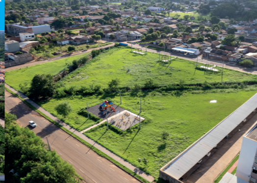
AQUISIÇÃO DE ÁREA NA AV. TIRADENTES COM URBANIZAÇÃO E INSTALAÇÃO DE PLAYGROUND
