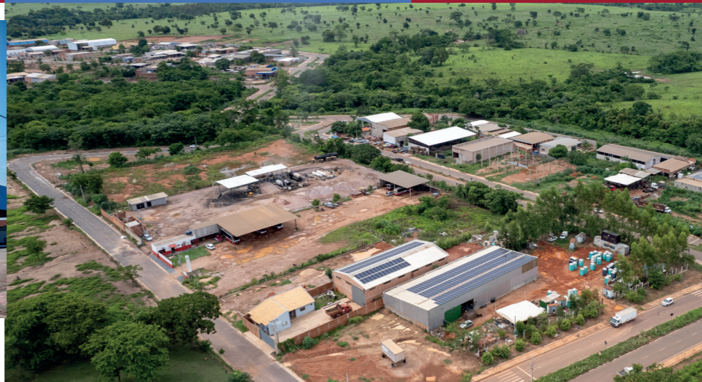
PAVIMENTAÇÃO E DRENAGEM EM 100% DO MICRO DISTRITO INDUSTRIAL ANÉZIO PEREIRA DE OLIVEIRA
