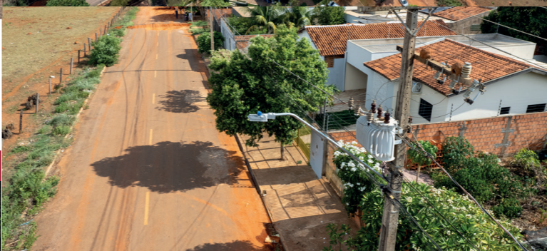
EXTENSÃO DA REDE DE ILUMINAÇÃO PÚBLICA RESIDENCIAL PARAÍSO
