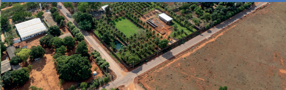
PAVIMENTAÇÃO ASFÁLTICA DO RESIDENCIAL PARAÍSO
