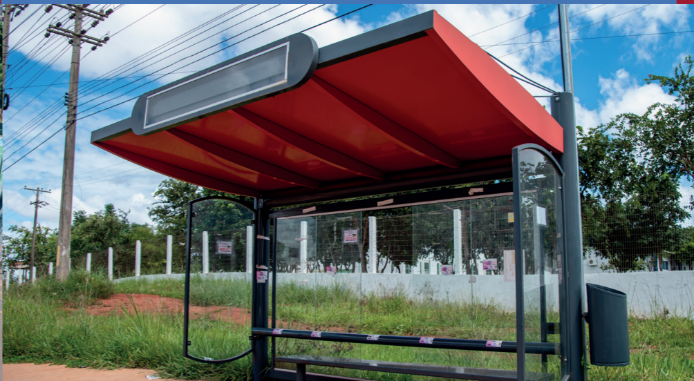
NOVAS COBERTURAS DE PONTOS DE ÔNIBUS
