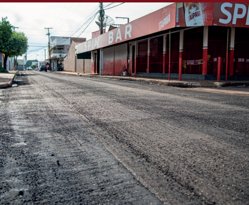
APLICAÇÃO DE MICORREVESTIMENTO EM TODA REGIÃO
