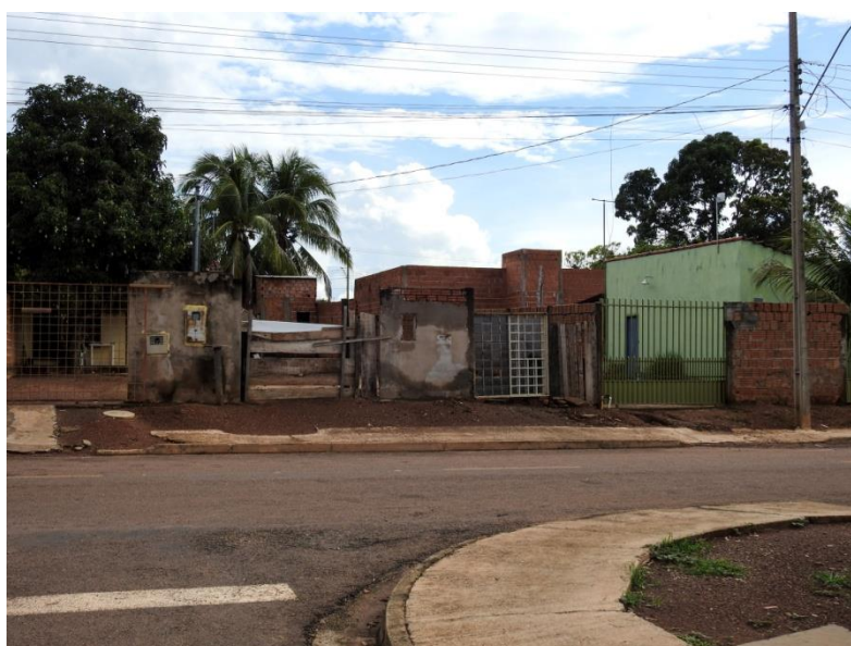
Foto 02 - A foto mostra o padrão de construção de moradias do bairro Jardim Liberdade
