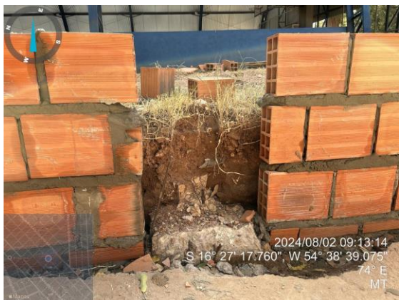
Figura 3 - Reaproveitamento da fundação existente (sem execução da viga baldrame, bloco e estaca)
