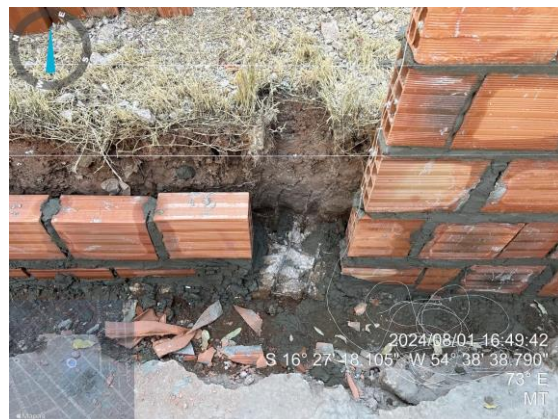
Figura 2 - Reaproveitamento da fundação existente (sem execução da viga baldrame, bloco e estaca)
