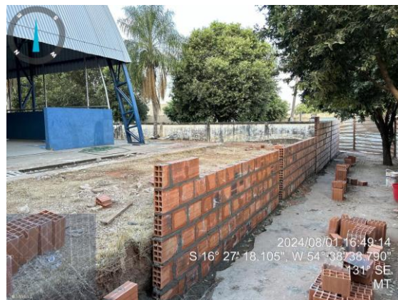
Figura 4 - Reaproveitamento da fundação existente (sem execução da viga baldrame, bloco e estaca)
