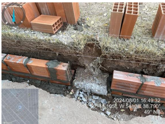
Figura 1 - Reaproveitamento da fundação existente (sem execução da viga baldrame, bloco e estaca)
