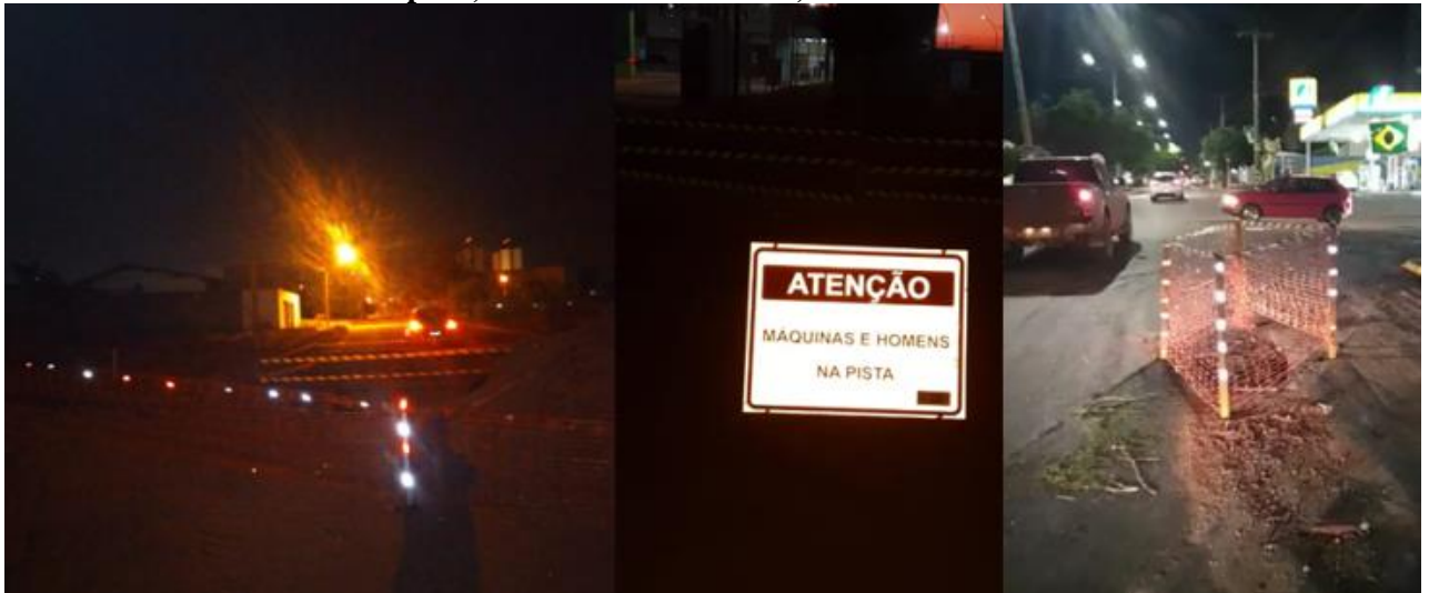
Figura 29: Imagem da esquerda - sinalização de valas com tela tapume e faixas refletivas, imagem do meio - cavalete retrorrefletivo e imagem da esquerda – afundamento com aplicação de faixas refletivas nas estacas.
