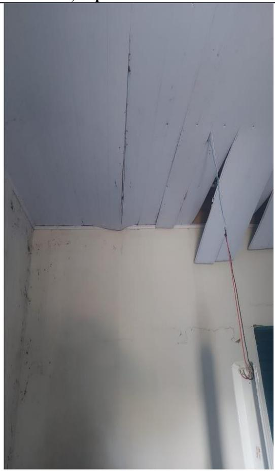
**Imagem 02 – Deterioração do Forro**
