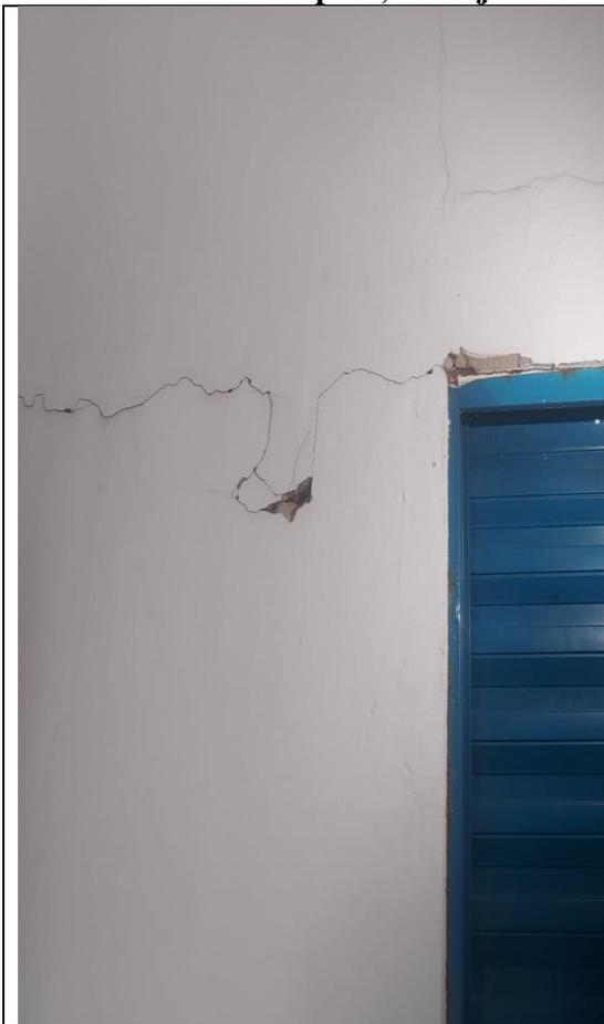
**Imagem 01 – Rachaduras na área interna da edificação**
