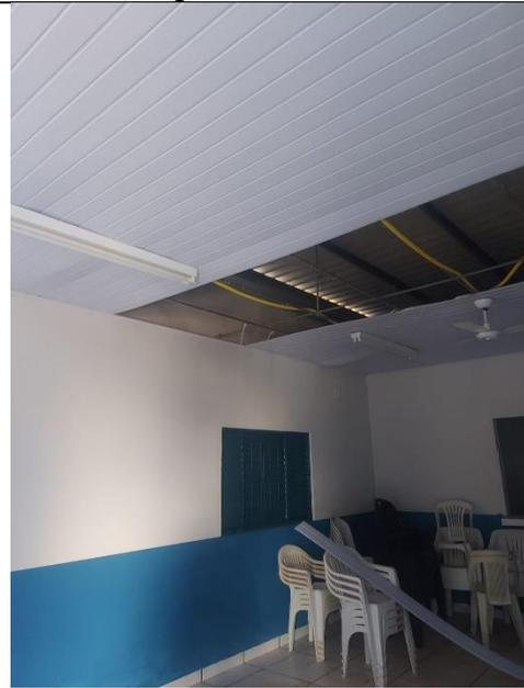
**Imagem 06 – Deterioração do forro**
