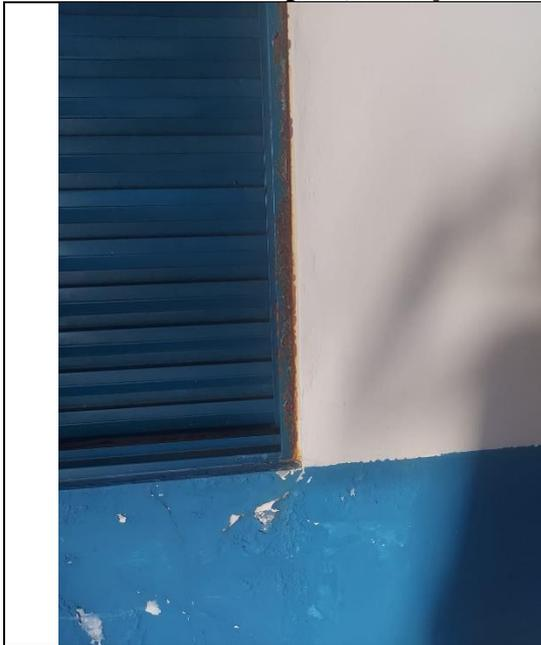
**Imagem 05 – Esquadrias sofrendo oxidação devido a umidade**
