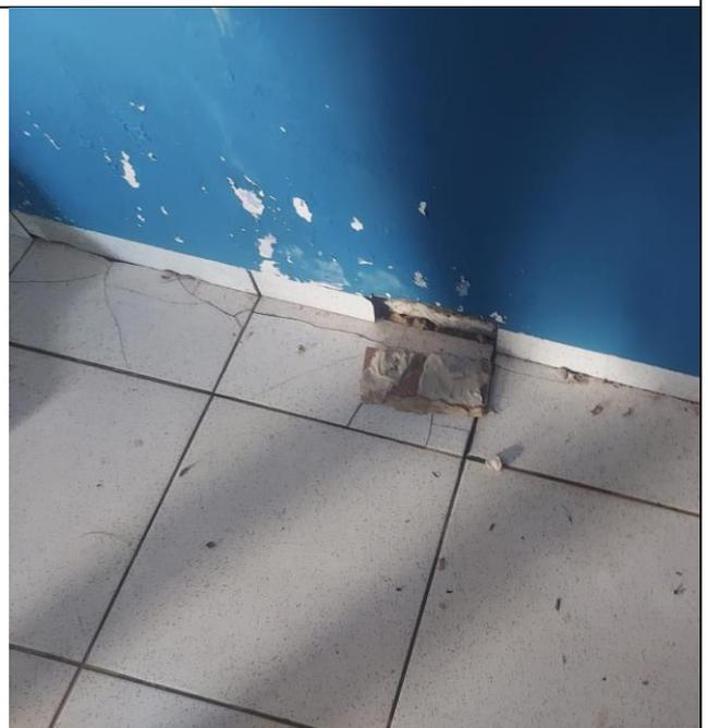
**Imagem 04 – Rachaduras provocando deslocamento**
