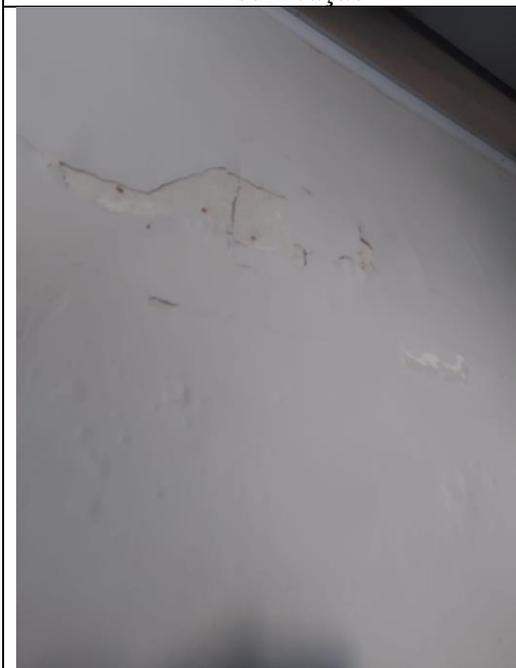
**Imagem 03 – Pintura danificada devido a umidade**
