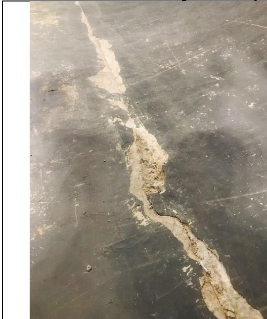
Imagem 01 – Esfarelamento presente na junta da pista
