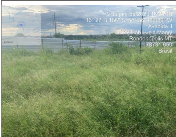
Figura 1: Mato e mau estado de conservação do espaço da obra.
