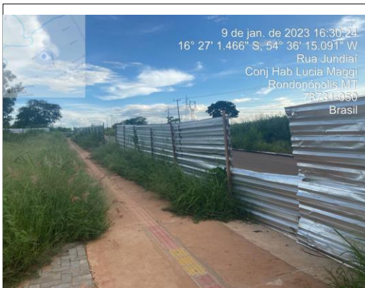
Figura 7: Falha no fechamento do tapume.
