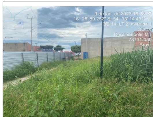
Figura 8: Falha no fechamento do tapume.
