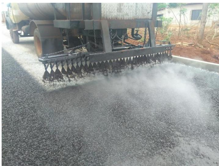
**Imagem 02** – Espargidor aplicando emulsão sobre a primeira camada de agregados
